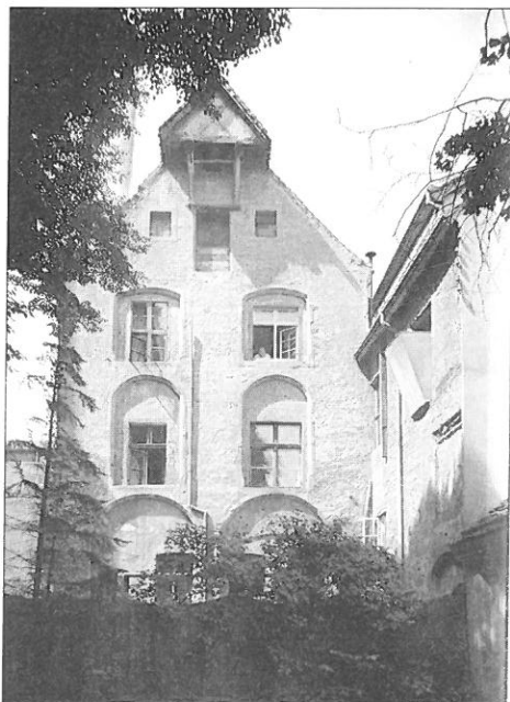
Ilustr. 21. Widok kamienicy przy Rynku 4 od strony podwórka. Fot. archiwalna ze zbiorów Muzeum Narodowego w Szczecinie
