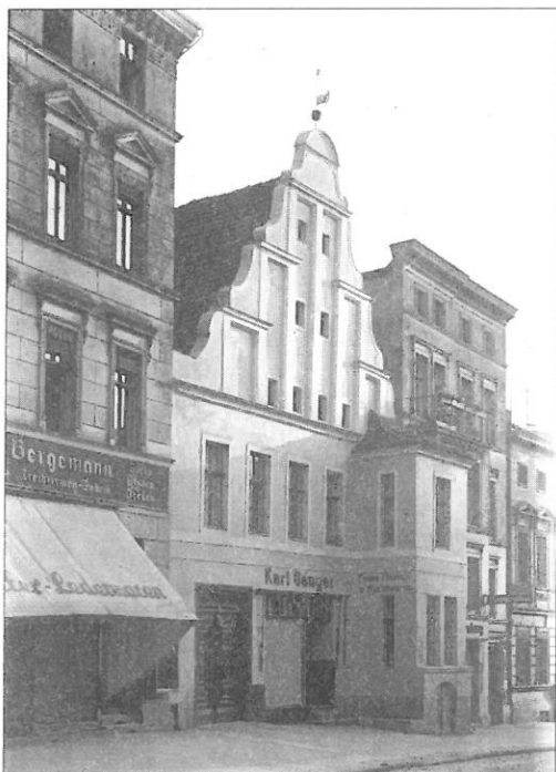
Ilustr. 8. Kamienica przy ul. Pyrzyckiej 36 (dziś ul. Mieszka I), wg stanu z 1936 r.
