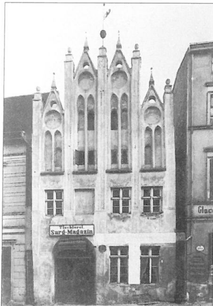
Ilustr. 6. Kamienica przy ul. Pyrzyckiej 12 (dziś ul. Mieszka I), wg stanu z 1891 r. Fot. archiwalna ze zbiorów Muzeum Narodowego w Szczecinie
